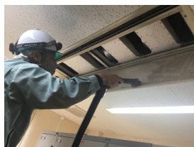
▲エアコンクリーニング
